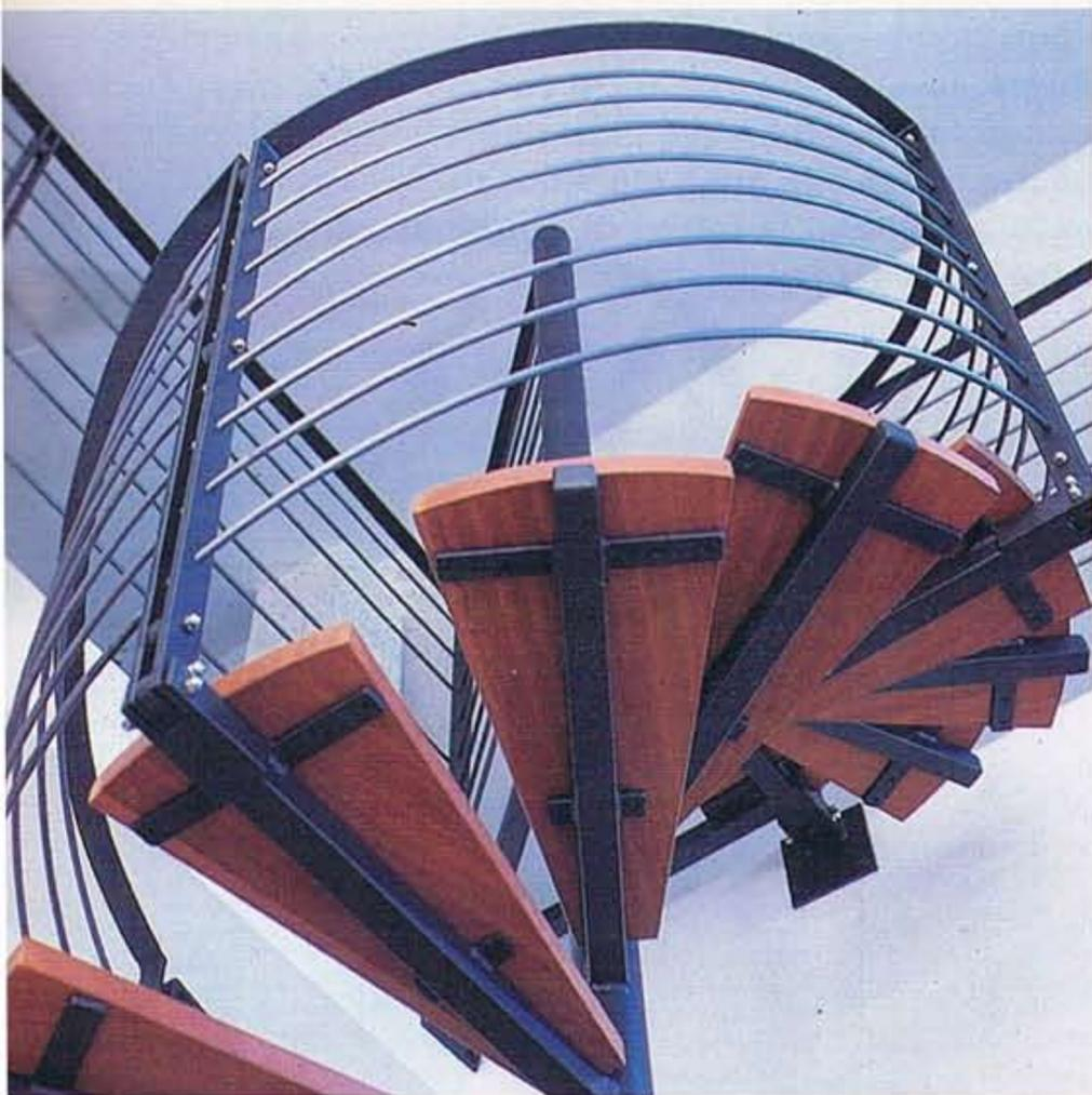
Un elemento al centro, con diramazioni superiori di portata; un corrimano realizzato con battitura a mano su incudine con ringhiera autoportante e balaustra interamente smontabile (per facilitare trasporto e installazione della scala), il tutto fissato con tondini di acciaio. Gli scalini sono in mogano verniciato opaco.
